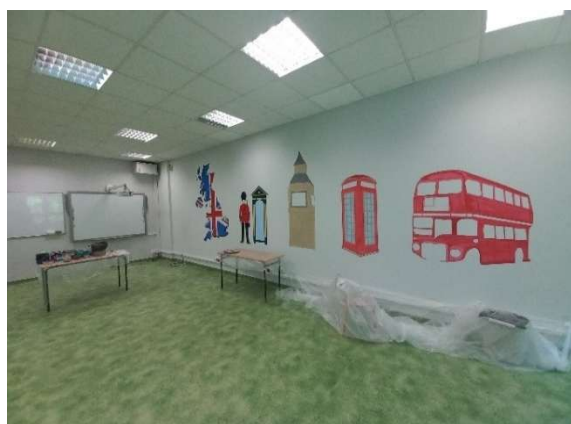
Zdjęcie 9. Remont Sali lekcyjnej
