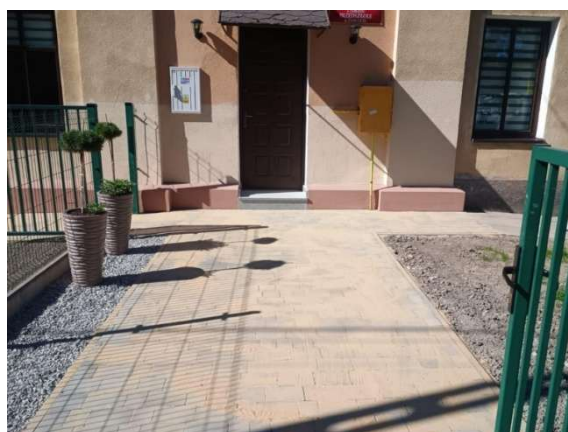
Zdjęcie 11. Wymiana nawierzchni podwórka – Przedszkole w Zabłociu
